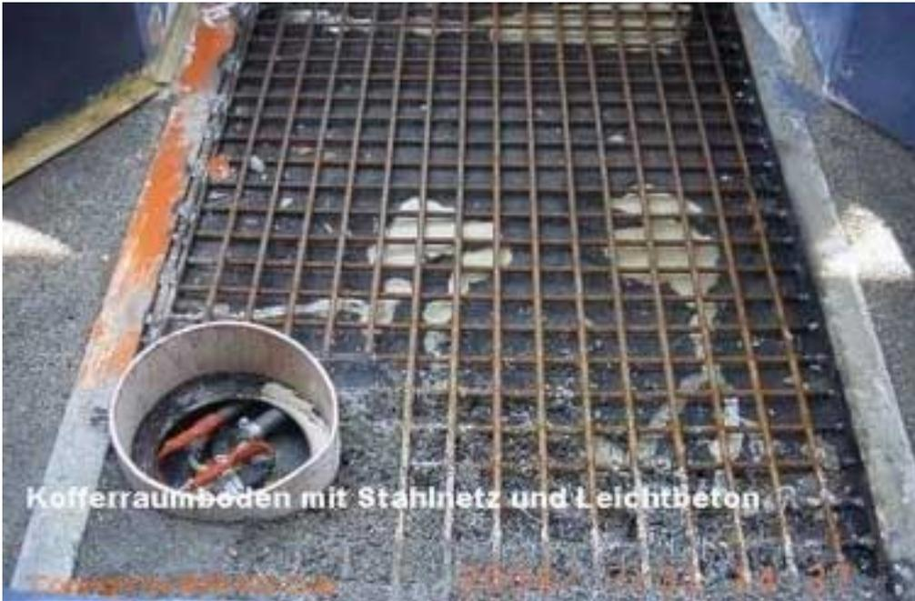
Kofferraumboden mit Stahlnetz und Leichtbeton
